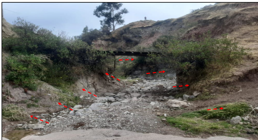
FIGURA N°02: COMUNIDAD DE PARIHUANCA, ZONAS EXPUESTAS ANTE UNA CRECIDA Y DESBORDE DEL RÍO PARIHUANCA EN AMBAS MARGENES, CADA AÑO LOS POBLADORES RENUEVAN EL PONTÓN POR SU CAIDA ANTE CRECIDA Y DESLIZAMIENTO DE TALUDES.
